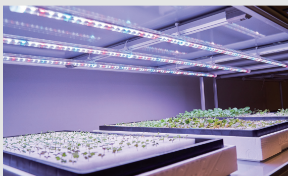
▲ LEDを使用した水耕栽培施設
